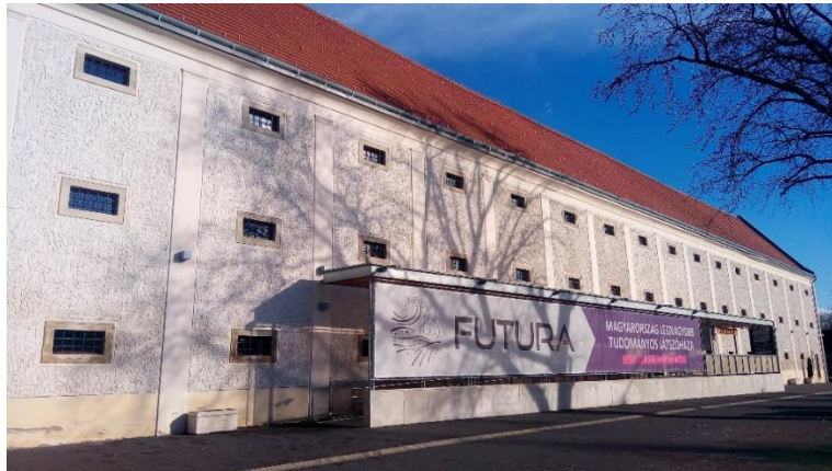
2. ábra: FUTURA – az egykori gabonaraktár épülete
